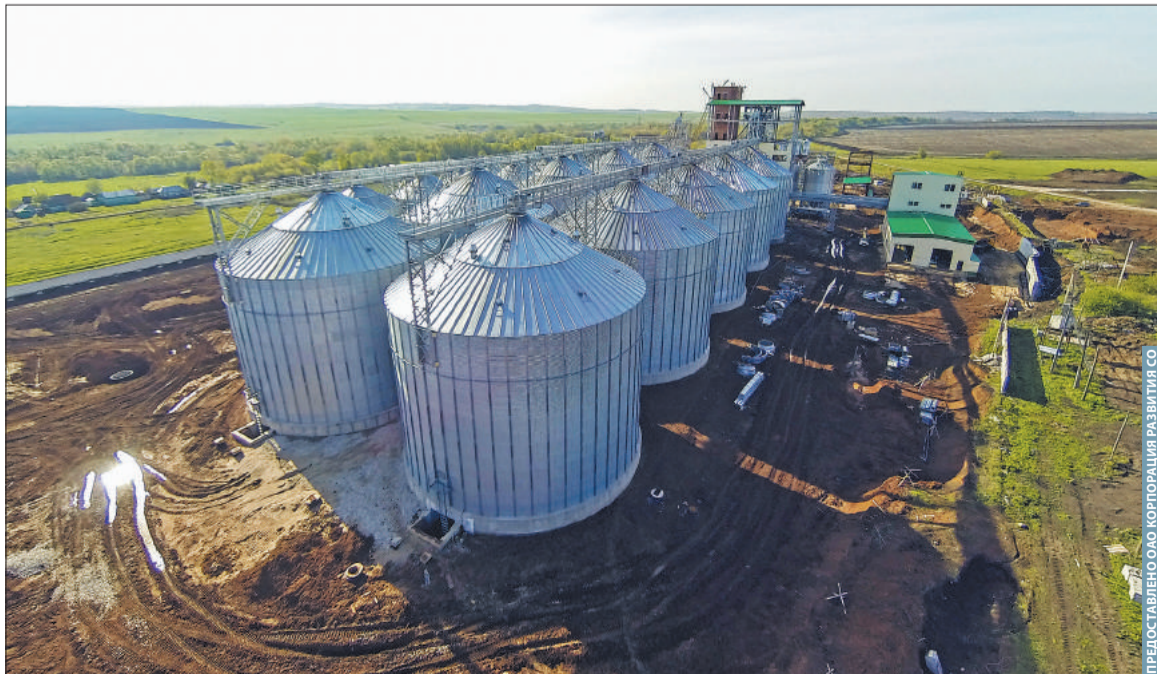
Элеваторная часть комбикормового завода в Кинель-Черкасском районе практически готова
